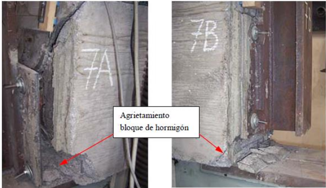
Figura 118 Agrietamiento bloque de hormigón y desprendimiento de grout (Villar, 2013)
