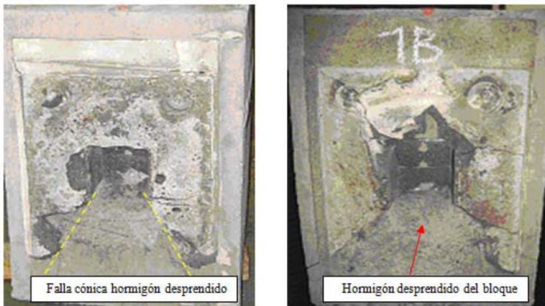
Figura 140 Zona de rotura hormigón llave de corte 1A y 1B (Villar, 2013)
