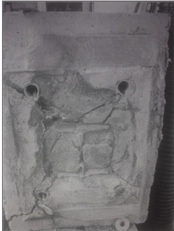
Figura 117 Bloque de hormigón después del ensayo (Silva, 2012)
