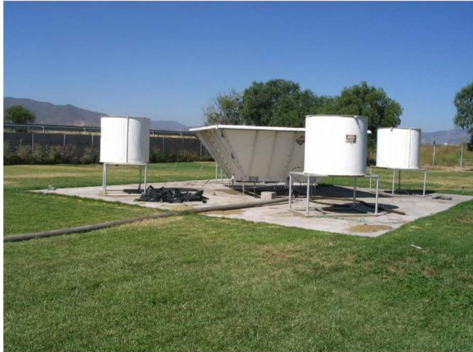
Figura N°3.1. Imagen del equipo LAP-3000 en su última ubicación (periodo 2003-2004) en dependencias del Aeropuerto Arturo Merino Benítez, zona Poniente en la Región Metropolitana, antes de ser desmantelado definitivamente por fallas de sistema. Al centro la antena del perfilador y las cuatro fuentes acústicas del Rass.
