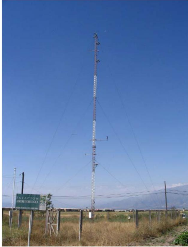
Figura N°3.3. Emplazamiento de la Torre de 24 m en el Centro La Platina, zona Sur de la Región Metropolitana. La Platina se ubica en la Av. Santa Rosa N°11.610, paradero 33 comuna de La Pintana.
