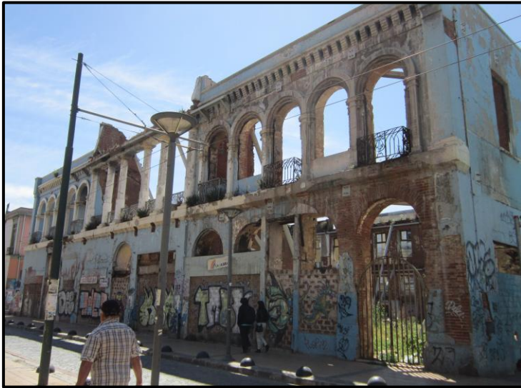
La fachada del palacio Subercaseaux se mantiene tal como lo dejó la explosión, como un recuerdo de lo que ocurrió ese sábado por la mañana.
