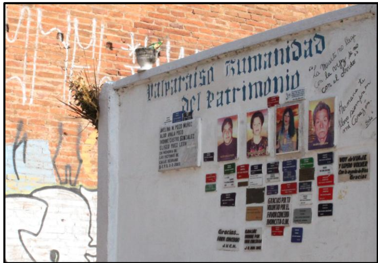
Memorial a las cuatro víctimas que dejó la explosión, en lo que sería la fachada del palacio Vial.
