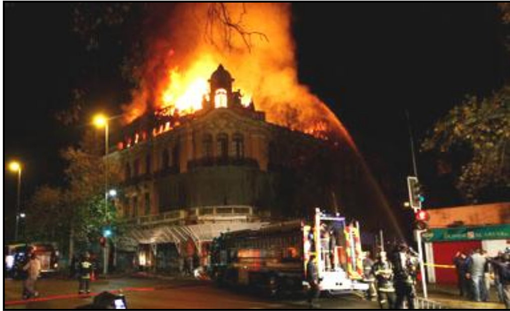
Palacio Iñiguez en Iquitos. Bomberos trabajando en el lugar.
