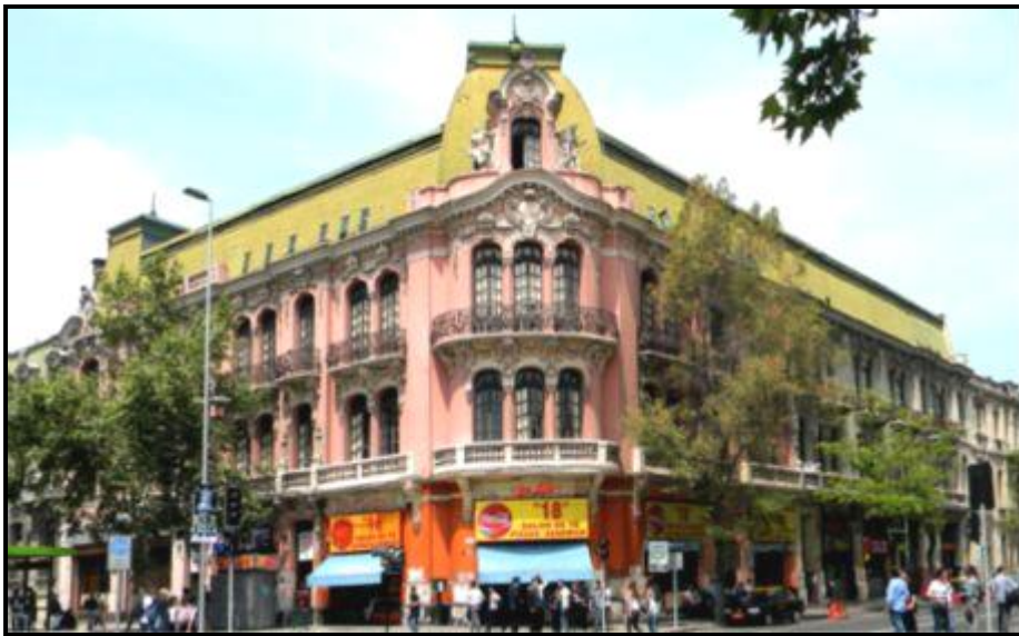
Fachada del Palacio Iñiguez antes del siniestro.
