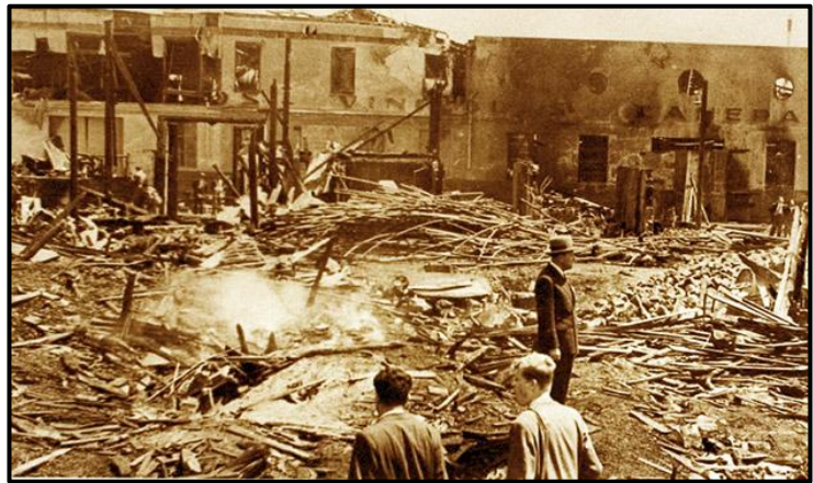
Escombros de la bodega de la Dirección de Vialidad y de la Barraca Schulze, ubicados en Avenida Brasil, esquina Freire.
