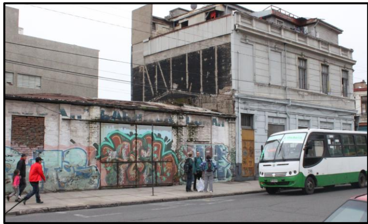
Aún se ven las murallas calcinadas en el edificio.
