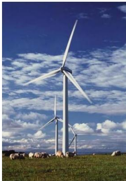
Figura 1.2 - Turbina eólica de eje horizontal de tres aspas [2].
