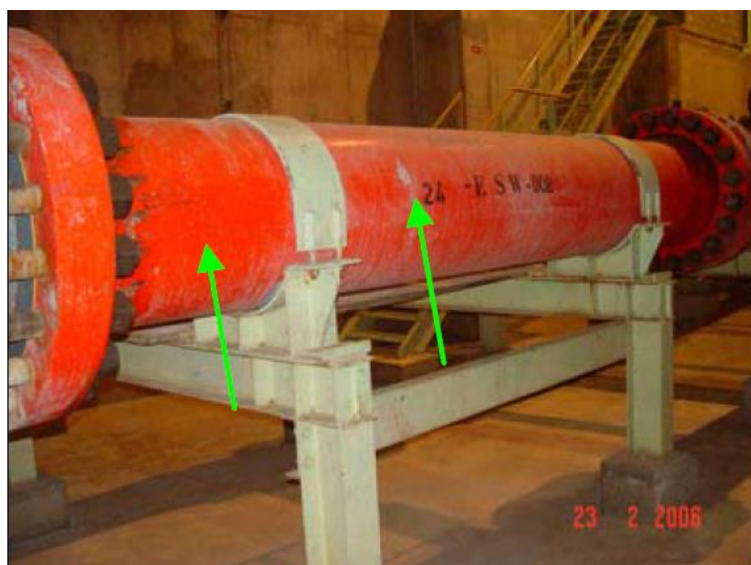
Figura 7.1.1: Pieza 24-ESW-008 con desgaste
