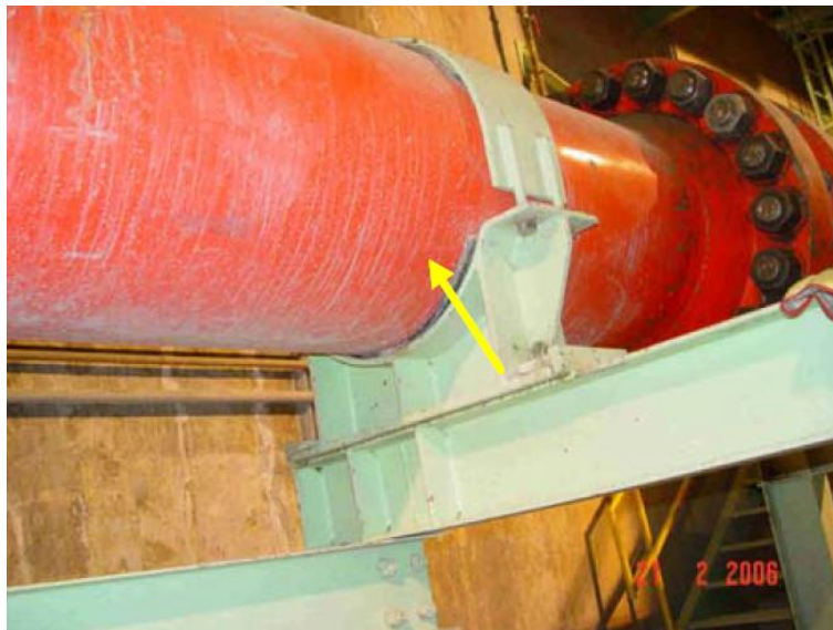
Figura 7.1.7: Pieza 24-ESX-013 con desgaste
