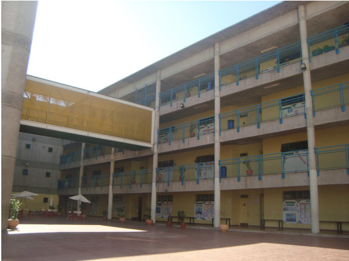
Ilustración 2: Niveles Colegio Simón Bolívar.
