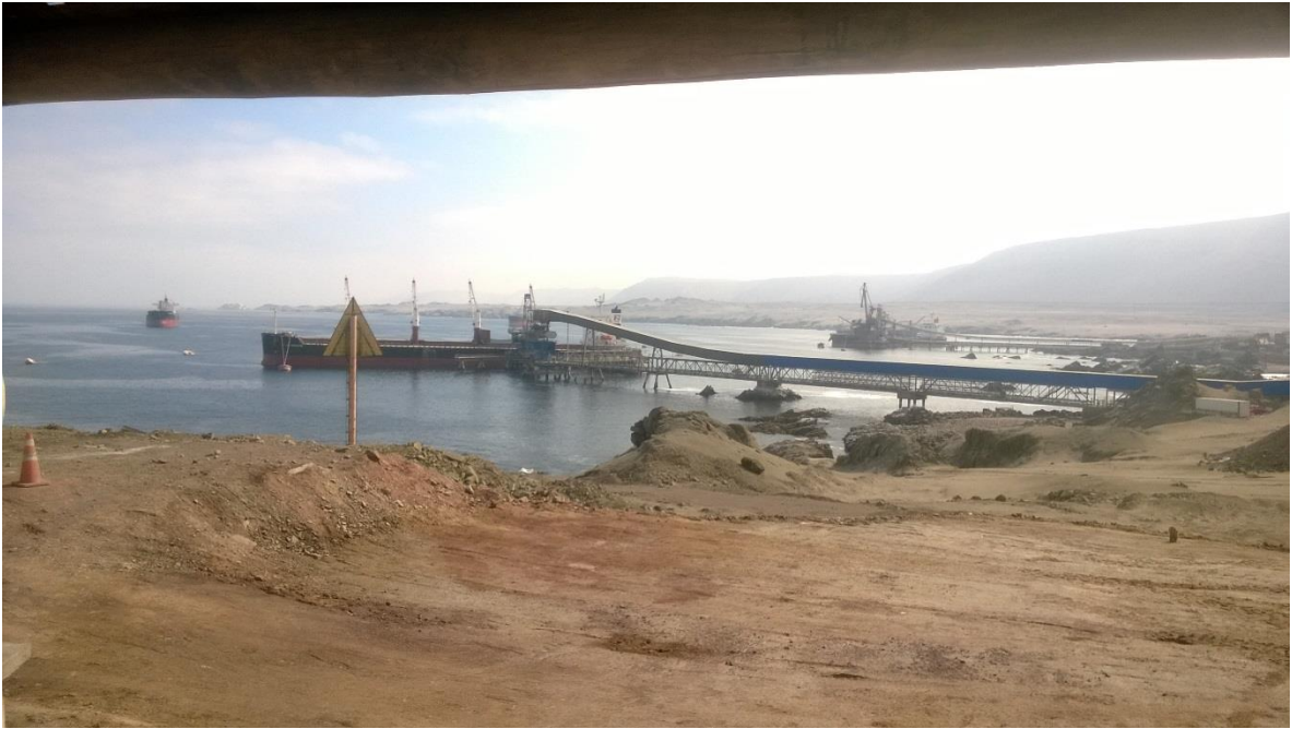
Ilustración 15 Correa transportadora ShipLoader en Puerto Patache
