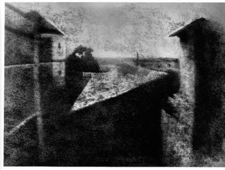
Figura n°1: Techumbre que se veía a través de la ventana del estudio de Niepce, correspondiente a la primera fotografía de la historia.
