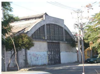
Fot. 5 Bodega en calle Edison
