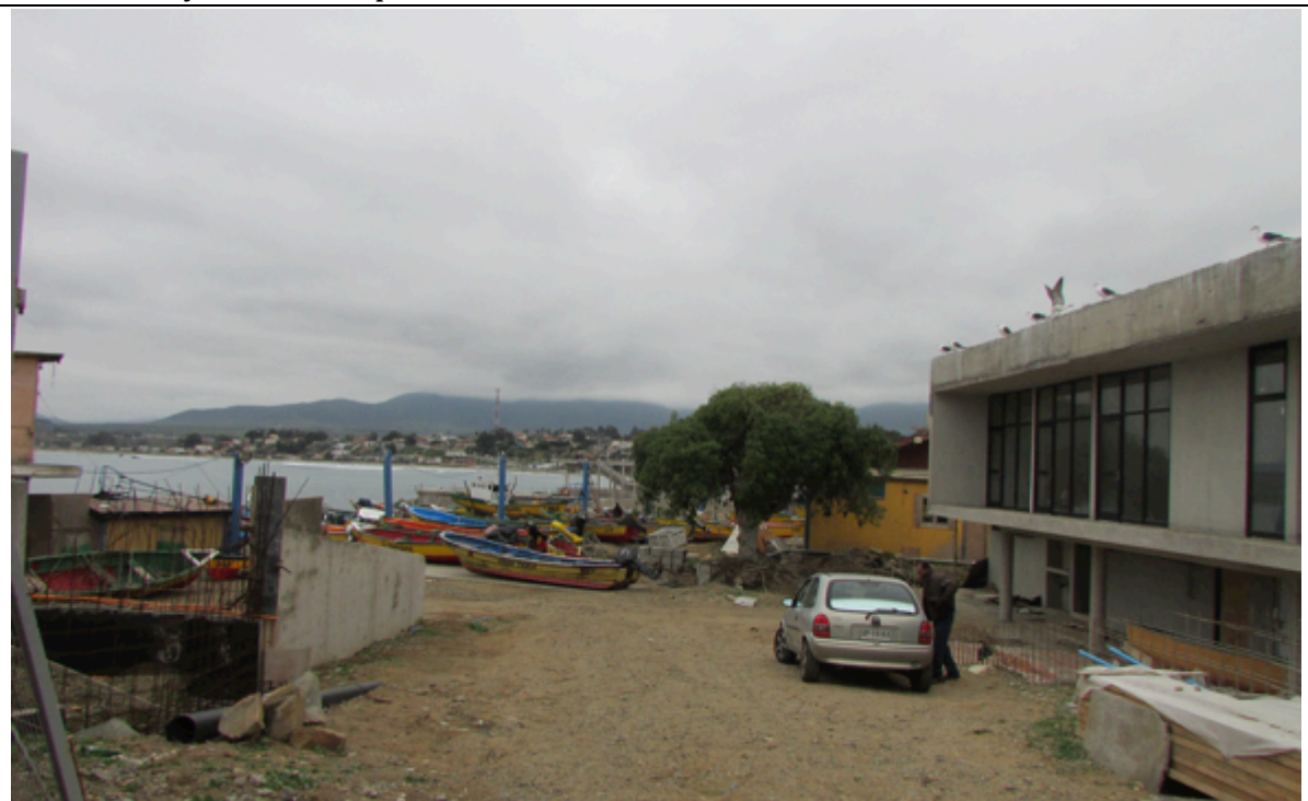
Construcción en obras nueva Caleta San Pedro
