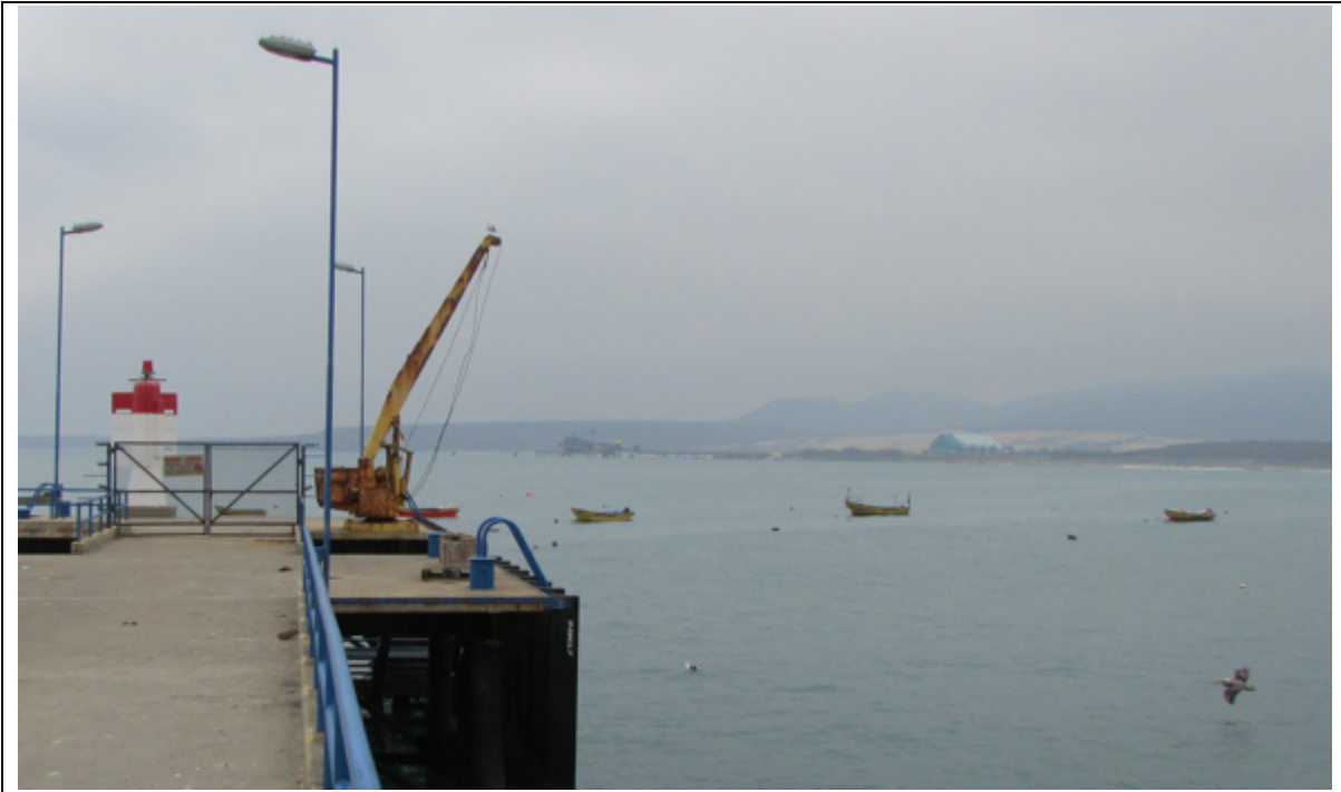
Muelle y grúa Caleta San Pedro
