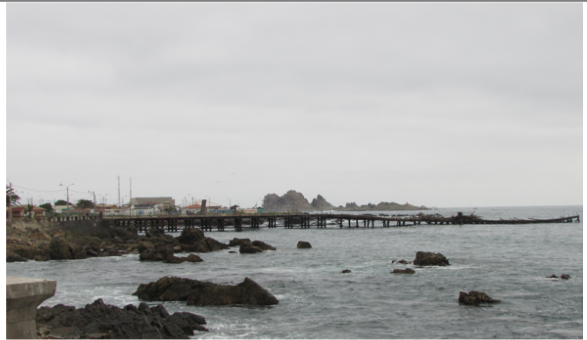
Muelle antiguo destruido
