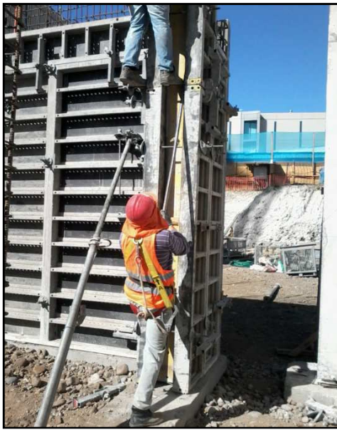
Figura 11. Aplome de moldajes
