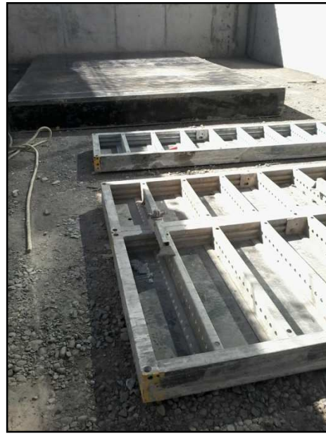
Figura 12. Zona de acopio, limpieza y aplicación de desmoldante
