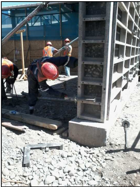
Figura 13. Instalación puntales para aplome de moldaje
