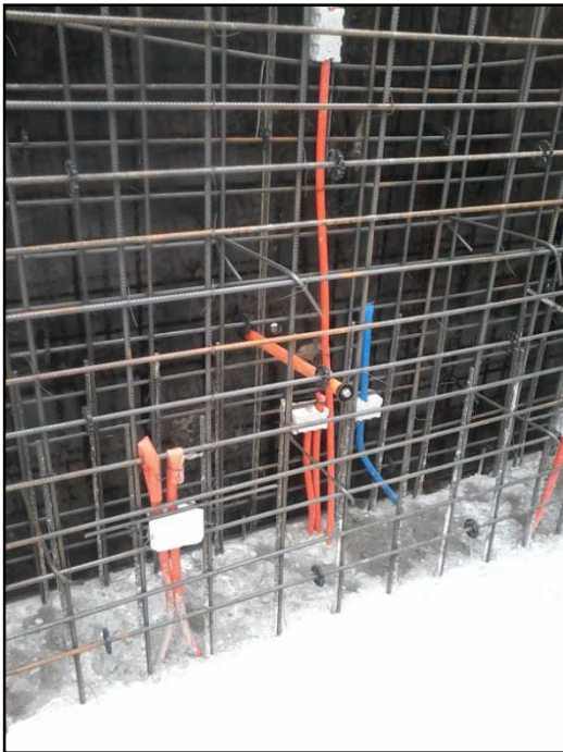
Figura 25. Instalaciones, enferradura
