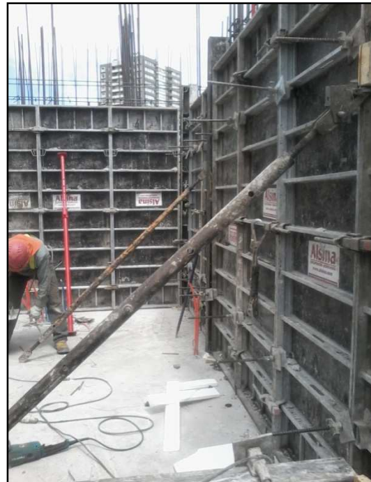
Figura 5. Puntales y aplome de moldaje
