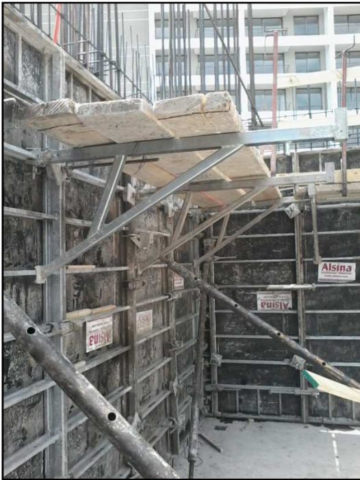
Figura 23. Plataforma de hormigonado
