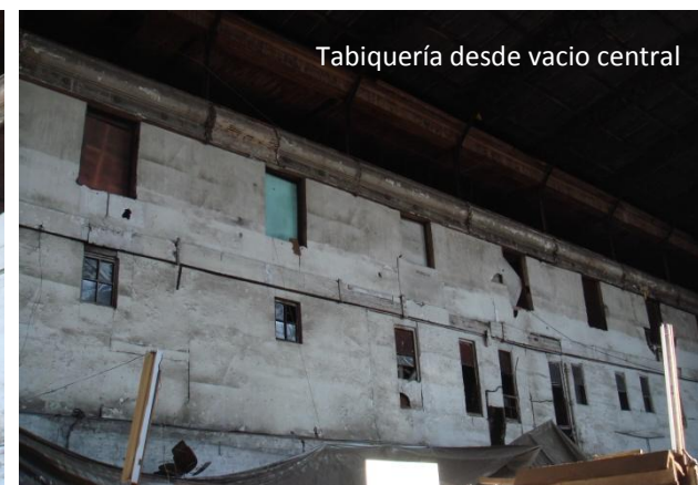
Muros de albañilería simple entre marcos de acero
