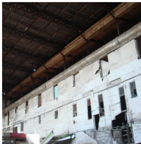
Muros de albañilería simple entre marcos de acero
