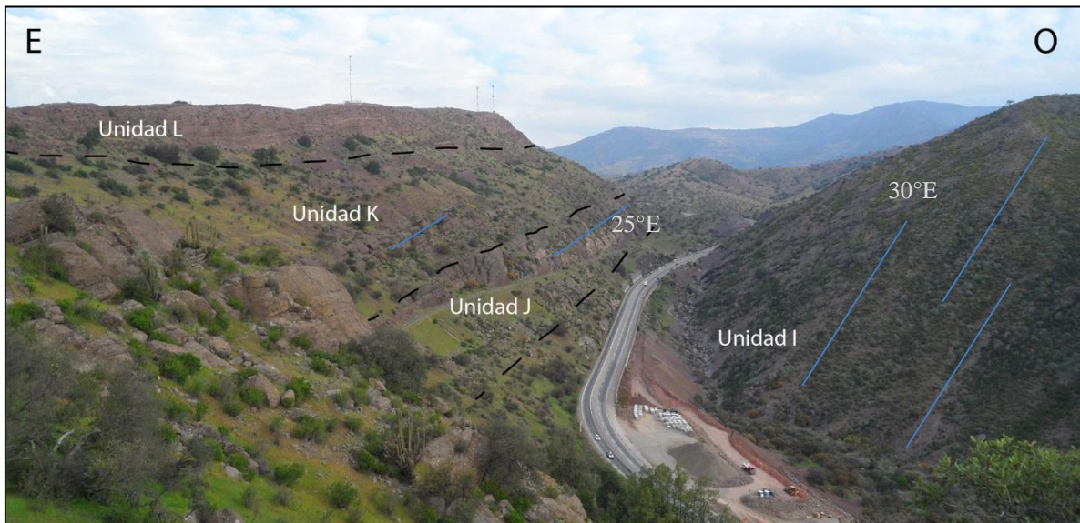
Figura 4.12: Vista hacia el sur en la cuesta Las Chilcas, donde se aprecia la disposición aproximada de las distintas unidades acá definidas.
