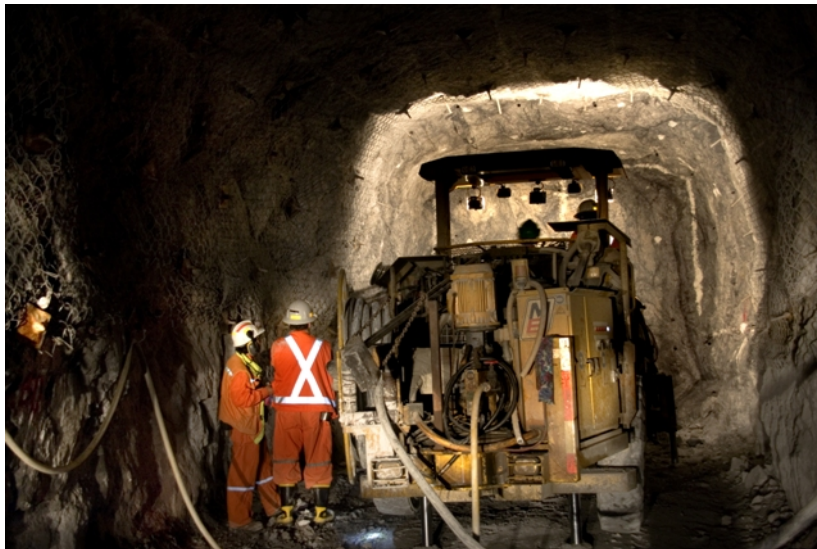
Figura 1.6: Galería a fortalecer en minería subterránea
