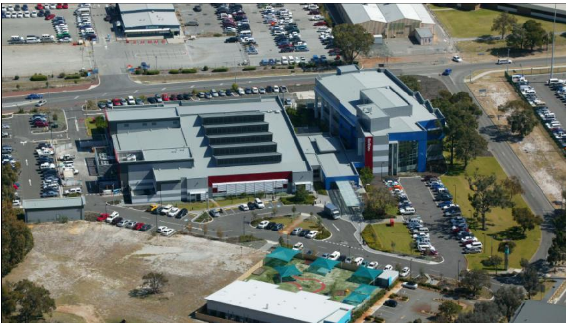
Figura 7-1: Centro de Operación en Perth, Australia
