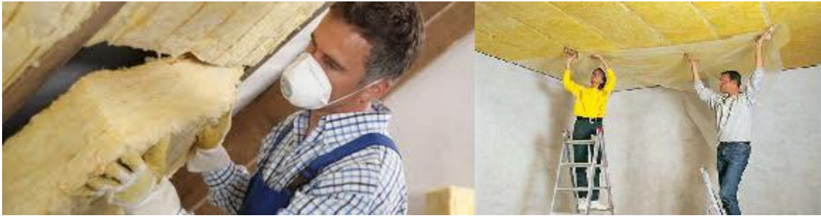
Figura 4.20: Instalación de aislante entre (izquierda) y debajo de las vigas (derecha)
