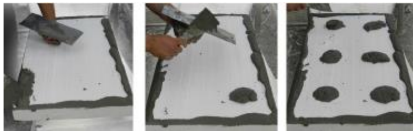
Figura 4.24: Colocación del adhesivo en la plancha aislante
