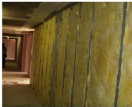
Figura 4.26: Instalación del aislante en tabique interior
