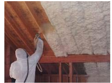
Figura 4.10: Instalación aislante proyectado
