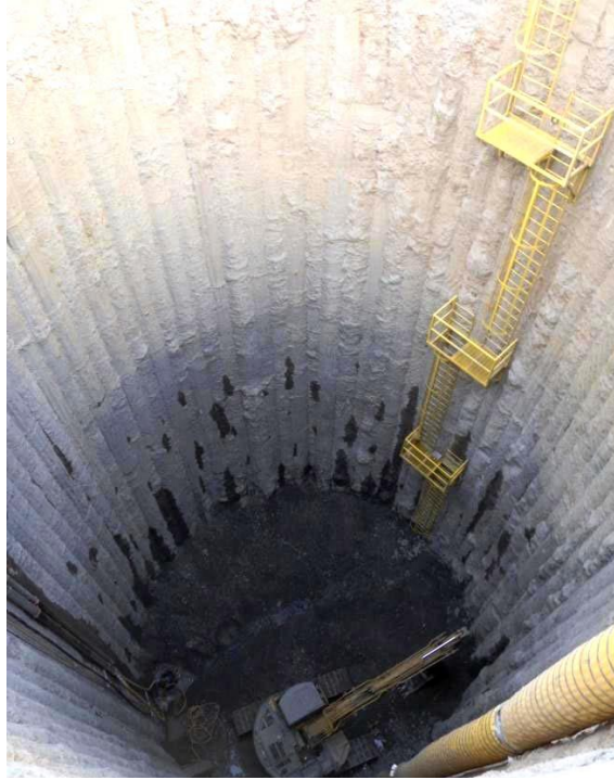
Figura 39: Pique de acceso de túnel New Irvington. Lindquist y Jameson (2011).
