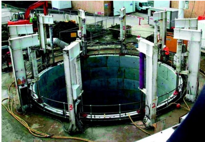
Figura 28: Pique construido con el método constructivo shaft sinking en Londres. Newman y Wong (2011).
