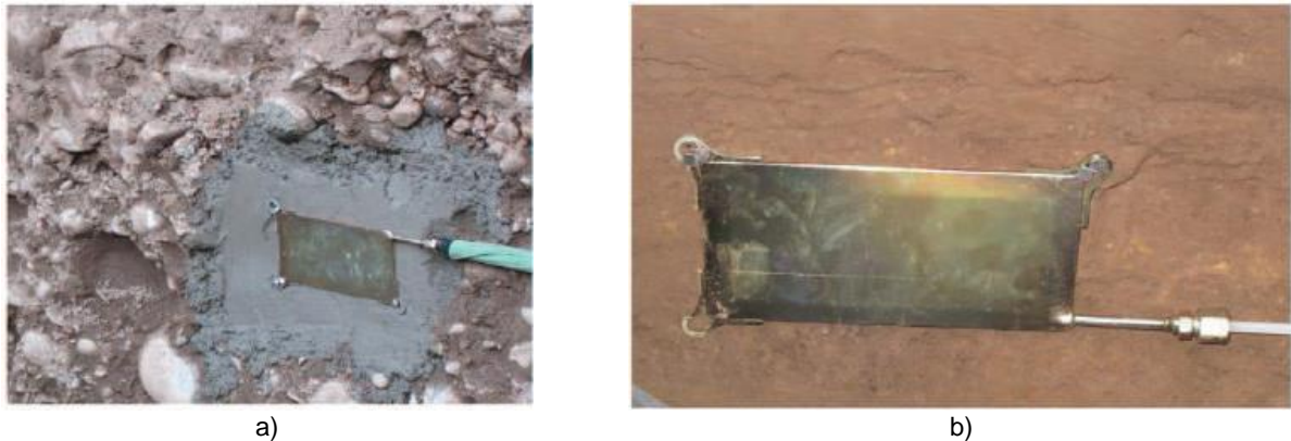
Figura 81: Celdas de presión hidráulica. a) Pique Plaza Chacabuco (Grava de Santiago). b) Pique El Cortijo (Finos del Norte).
