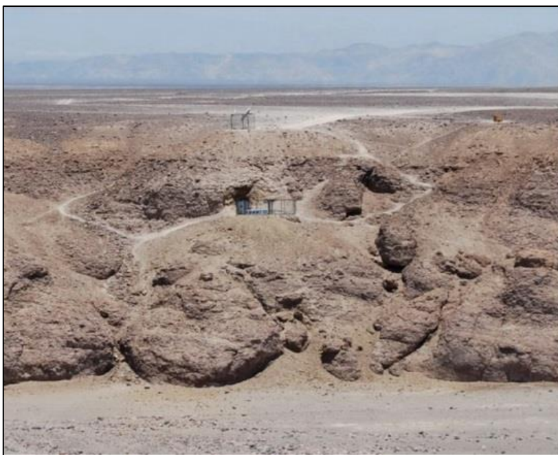
Figura 32. Estación Quebrada de Aricilda (PB11)
