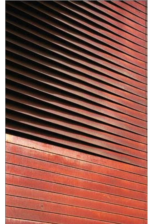
Imágen, arriba Signal Box, Herzog y De Meuron, Basel
