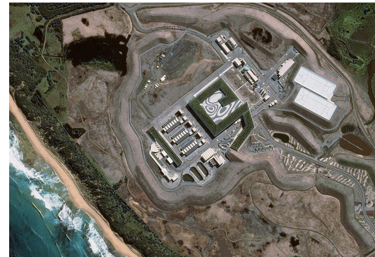
[9] Planta Desalinizadora Victoria, Australia.
