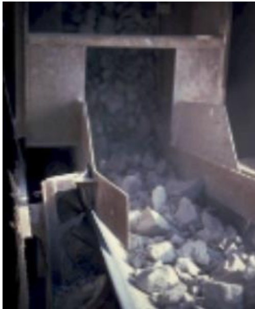
Figura 2.43: Problema de atollo en un punto de transferencia. [Fuente: Dewicki y Mustoe, 2002.]
