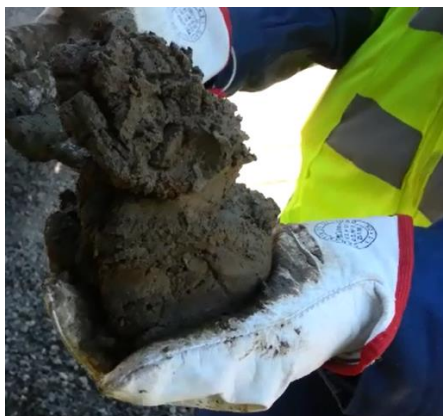
Figura 5.5: Material extraído de las paredes del punto de transferencia. [Fuente: Foto tomada por el autor.]
