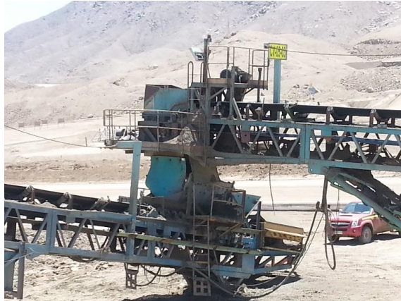
Figura 5.2: Foto del PT-01. [Fuente: Foto tomada por el autor.]
