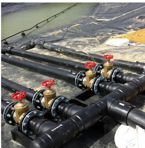
**Figura 6.10 Esquema de control con valvulas en Manifold.**
