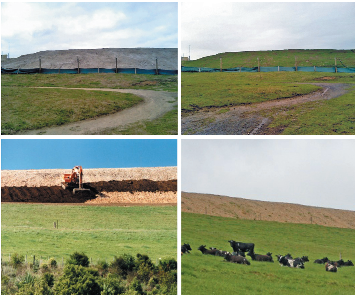
Fig. 21: Imágenes de la restauración progresiva de la Mina Martha. Arriba, la revegetación de los residuos mineros masivos. Abajo, el re contorneo de las áreas dispuestas para usos productivos y la coexistencia de actividad ganadera y minera. Fuente: Oceana Gold
