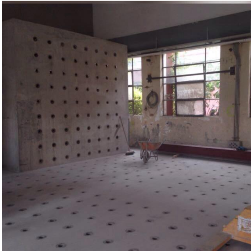
Figura 3. 1 Losa de reacción
