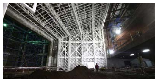
Estado actual del avance de las obras
