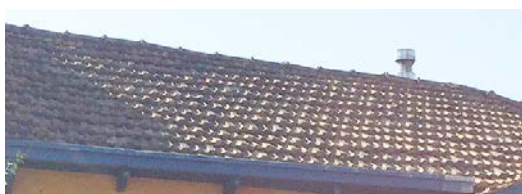
Cubierta de teja cerámica
