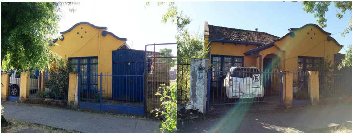
Fotografías de la vivienda a preservar (C/ Isabel Riquelme, 356)
