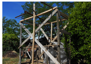
▼ Andamio de palos.
