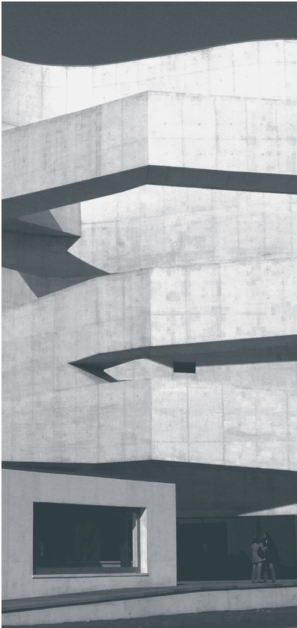
Exterior de la Fundación Iberê Camargo, obra de Álvaro Siza en Porto Alegre, Brasil. 2008
