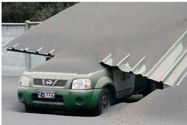
Figura 63: Colapso de gimnasio de cuartel policial, Ensenada
