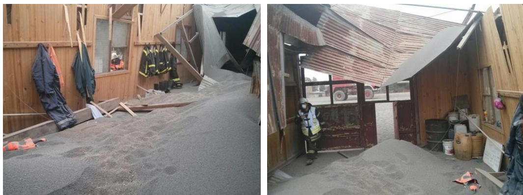
Figura 65: Colapso de techumbre de 7ma. Brigada Vicente Pérez Rosales
