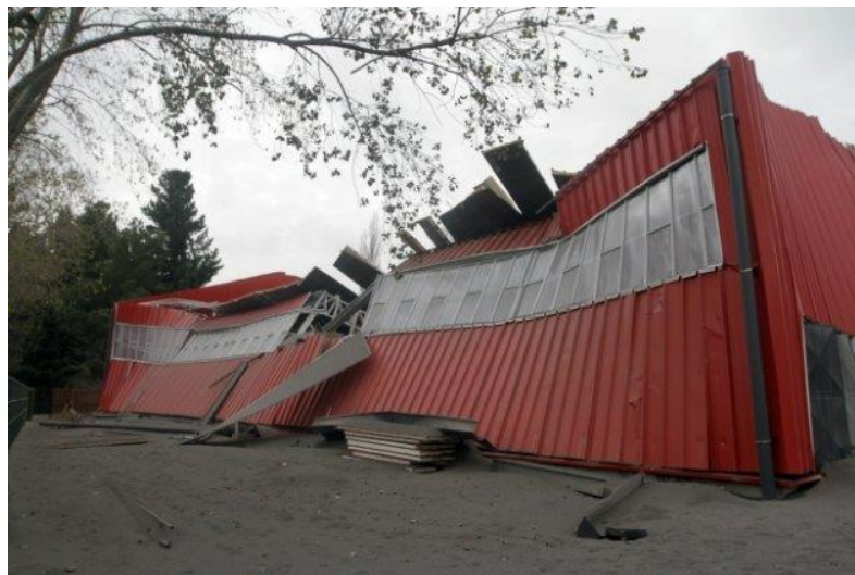
Figura 64: Colapso de gimnasio de escuela Epson, Ensenada
