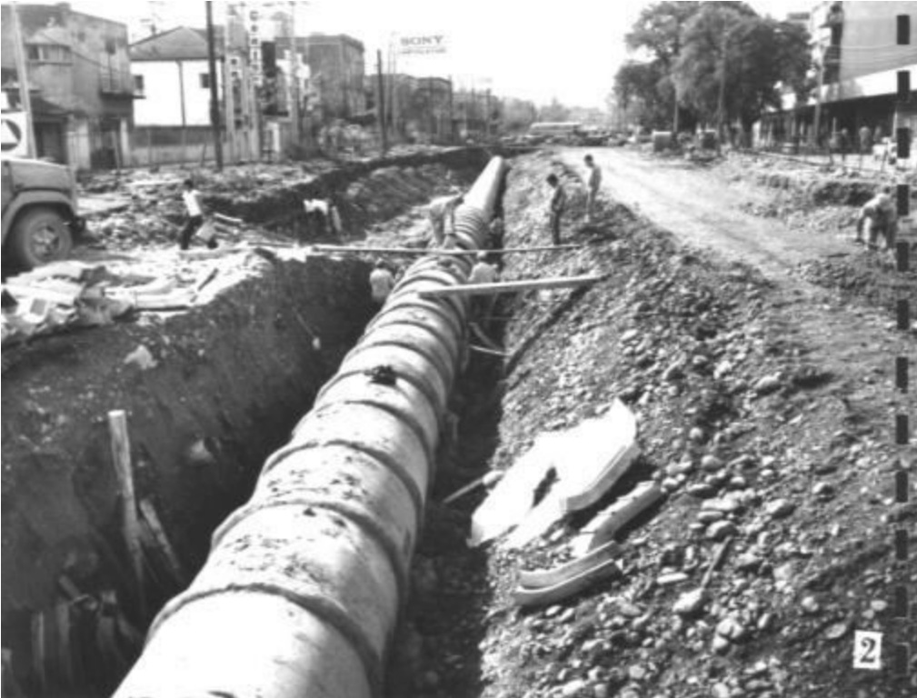
Trabajos de cambio de servicios en Avenida Apoquindo, sector 3-T, 1980. Fuente: Archivo Fotográfico Metro.
