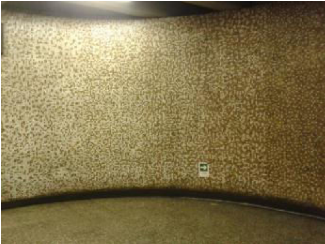
Degradé de mosaicos en escalera de salida de estación Salvador. Foto del Autor. Julio de 2013.
