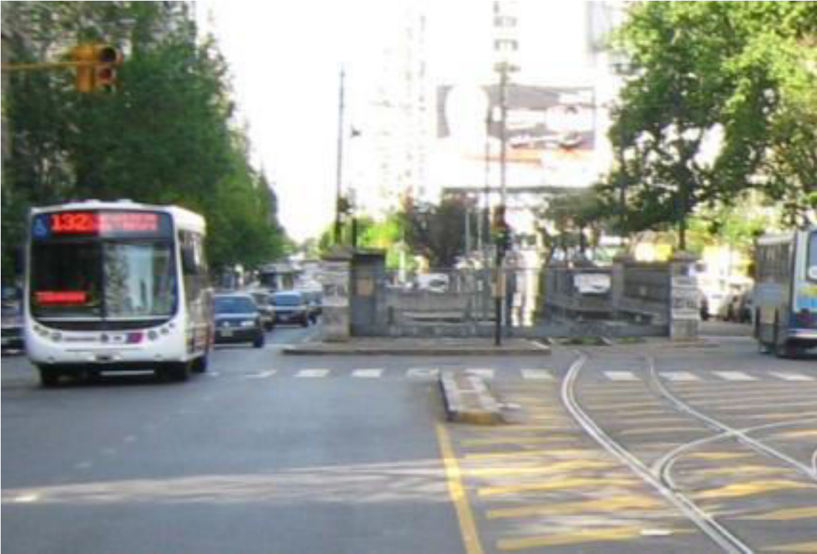
Escotilla de salida desde tranvía subterráneo a la Avenida Rivadavia en Buenos Aires. Foto del autor, octubre 2008.
