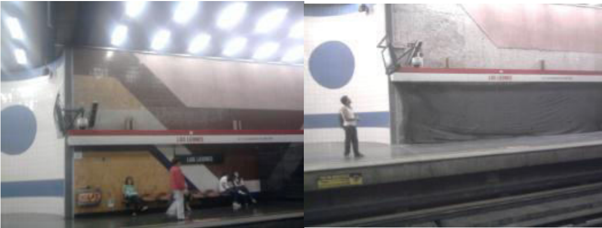
Estación Los Leones, proceso de retiro de mosaico antiguo. Enero de 2011, fotos del autor
