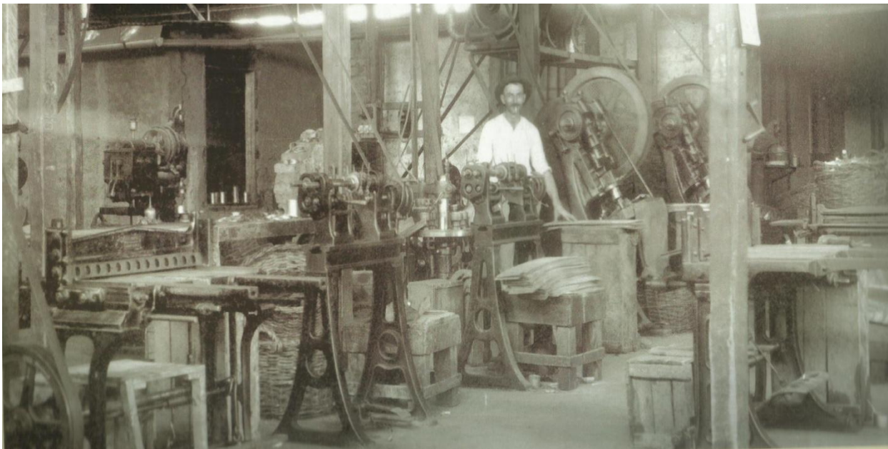
Imagen 15. Primeras instalaciones de la fábrica en San Felipe
