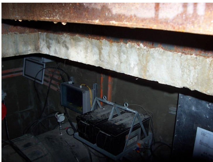
Ilustración 20 Vista interior de una cámara de sectorización
