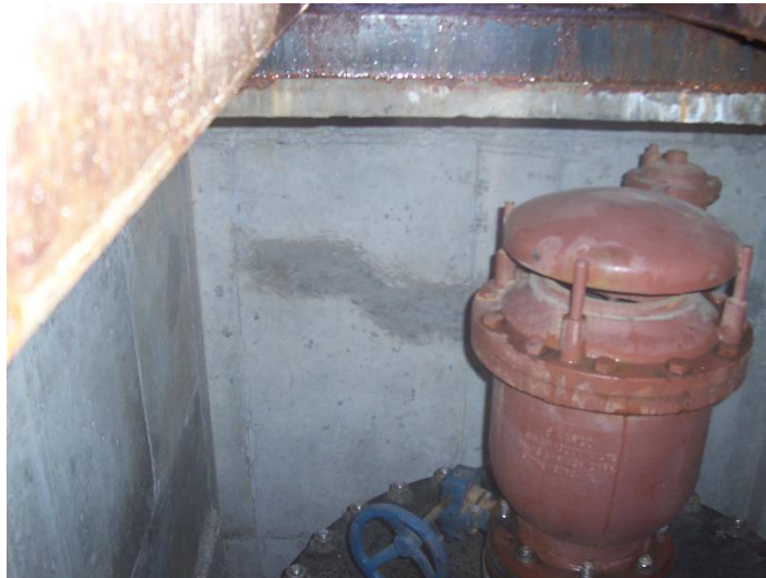
Ilustración 25 Vista interior cámara de inspección ventosa
