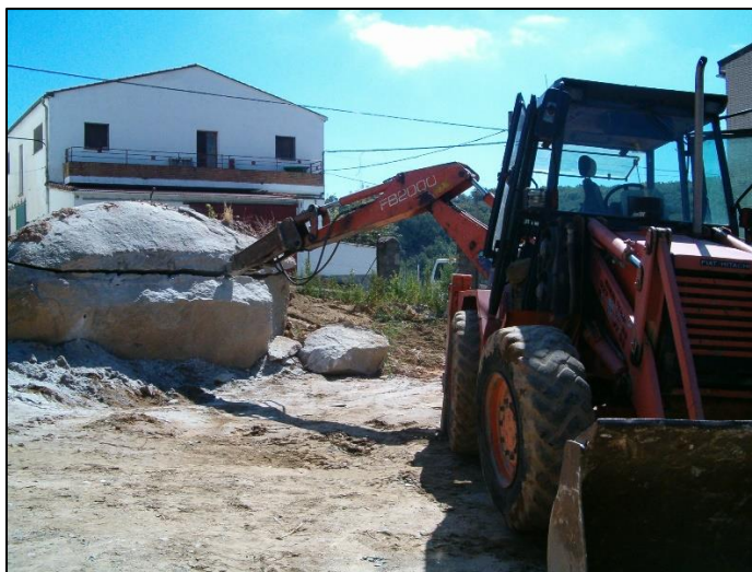
Ilustración 50. Equipo dozer con dispositivo de cuña hidráulica.
