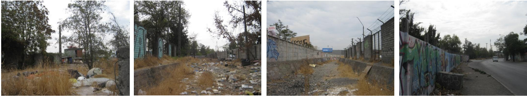
Espacios o vacíos urbanos en desuso, deterioro y abandono, barrio industrial ex Estación Yungay, borde Avenida Matucana Fuente: Propia
