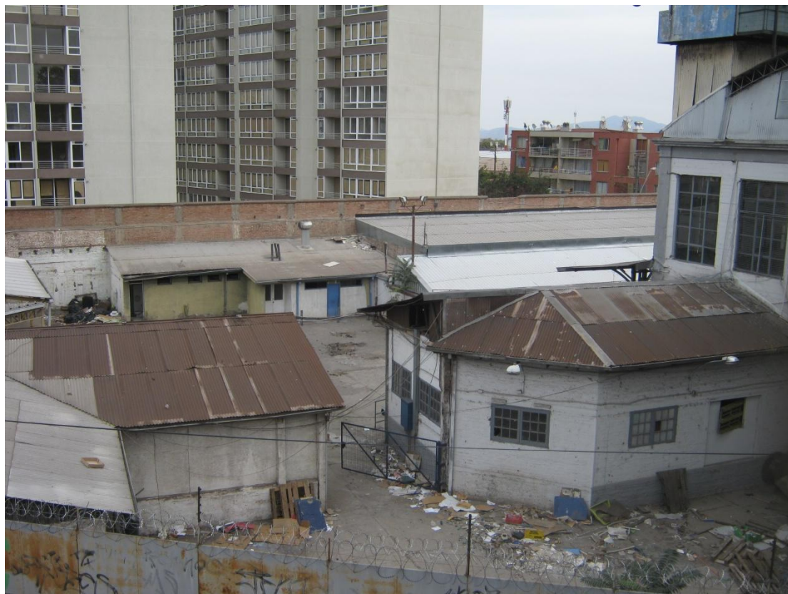
“Espacios del abandono y el deterioro”: actual mixtura y cohabitación entre vivienda y espacios productivos en el barrio industrial ex Estación Yungay Fuente: Propia
