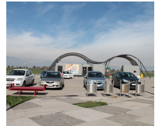
Fotografía zona de baños y estacionamientos Fuente: Elaboración Propia
