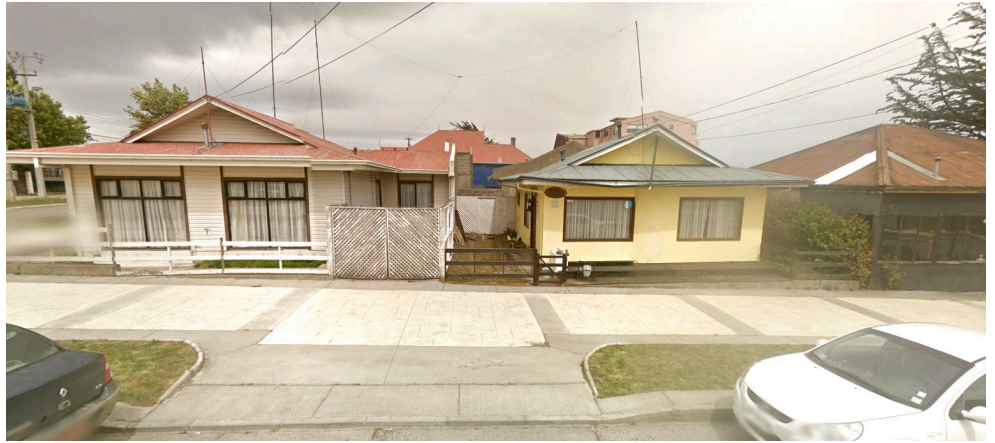
Fig. 24 Calle Eberhard, Centro urbano fundacional. Fuente: www.google.cl/maps
