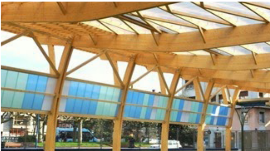
Referentes de pilares y anclaje a terreno en madera laminada http://blogtecnicodelamadera.blogspot.com
