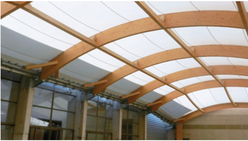
Ejemplo de cubierta de tela con estructura de madera. http://www.espaciocubierto.com/arquitectura-textil
