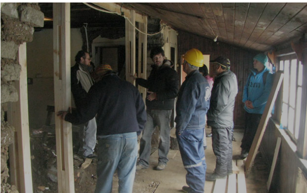
2. Inspección de obra casa Mariano Latorre.
