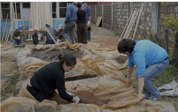
4. Selección de la tierra, en trabajos de Casa Mariano Latorre.
