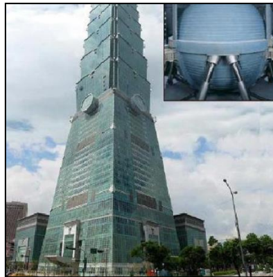
Figura 1-1. Torre Taipei 101, Taiwan, implementación de TMD en la estructura [69].
