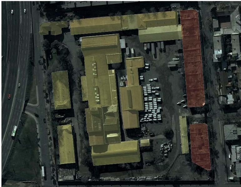
■ Estado de conservación regular ■ Estado de conservación malo
