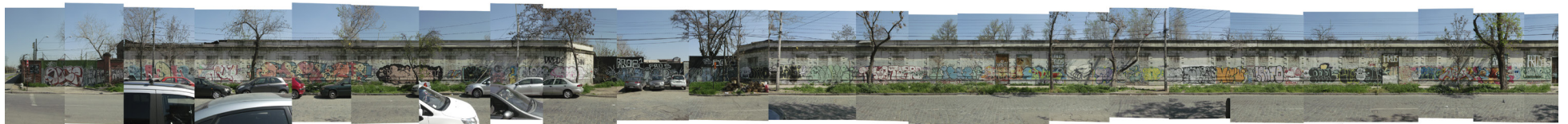
Fachada oriente de la manzana
