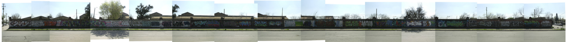
Fachada sur de la manzana
