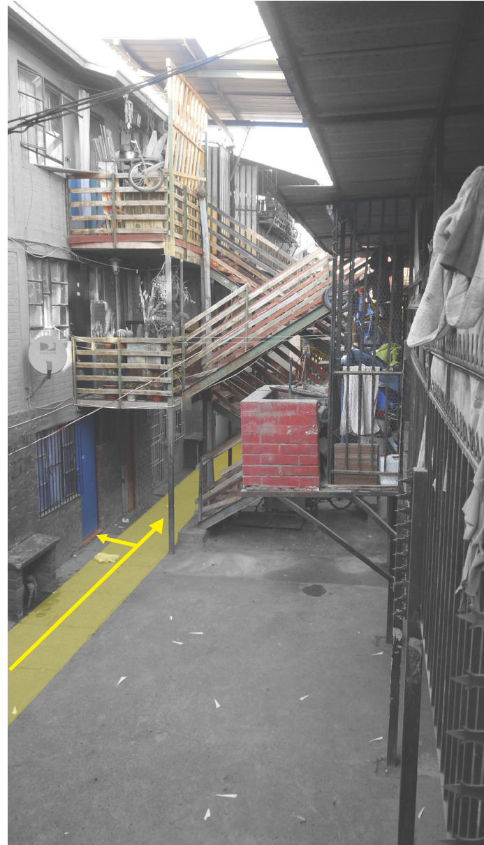
Fotografía 11: Pasaje interno en bloque de vivienda social en Villa San Miguel IV en Bajos de Mena, Pucallpa Fuente: Elaboración propia
