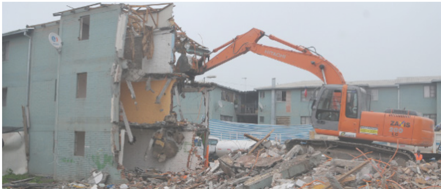
Fotografía 7: Demolición en Villa Francisco Coloane en Bajos de Mena, Puente Alto Fuente: MINVU, 2013
