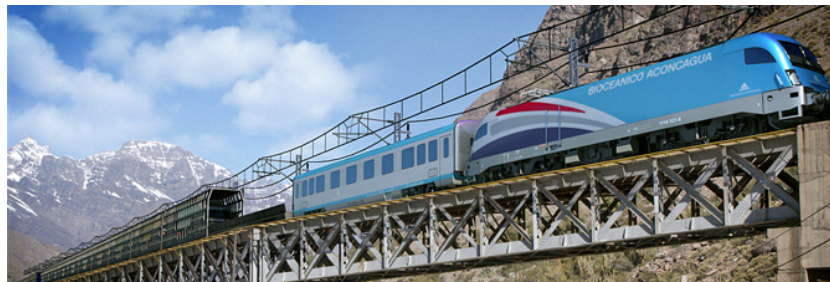
FIGURA 33 | IMAGEN PROYECTO CORREDOR FUENTE | HTTP://WWW.CORREDORBIOCEANICOACONCAGUA.CL
