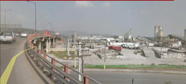
A2- Acceso por Eduardo Frei Montalva.
