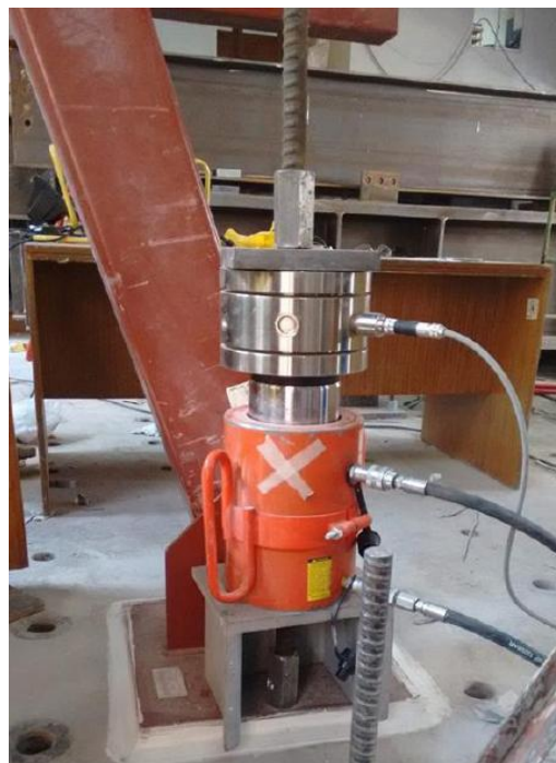
Figura 5.1: Sistema de tensado de barras de anclaje (foto: Núñez, 2016).
