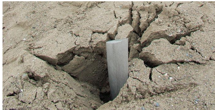
Figura 3.8: Generación de zona alterada por colocación de PVDs (Cofra, 2014)
