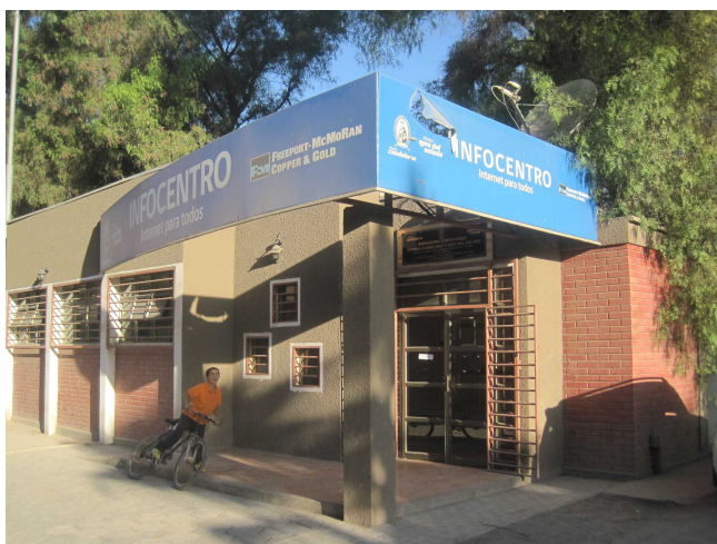
Acceso Telecentro Candelaria existente.
