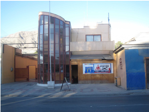
Vista Fachada Cuartel de Bomberos por Av. Miguel Lemeur.
