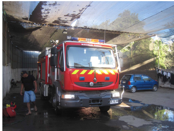
Sala de Maquinas Cuartel de Bomberos, notese la cubiera resuelta con una malla geotextil "malla de kiwi".
