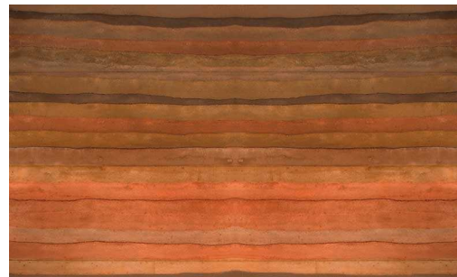
Textura muro de Tapial.
