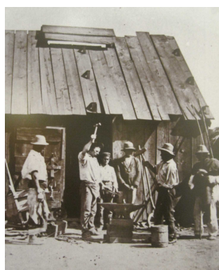
Construcción de Ferrocarril de Caldera a Copiapo 1850
