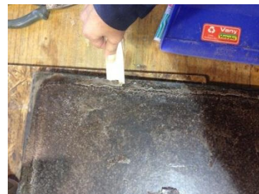
Figura 43: Desmoldado con espátula.
