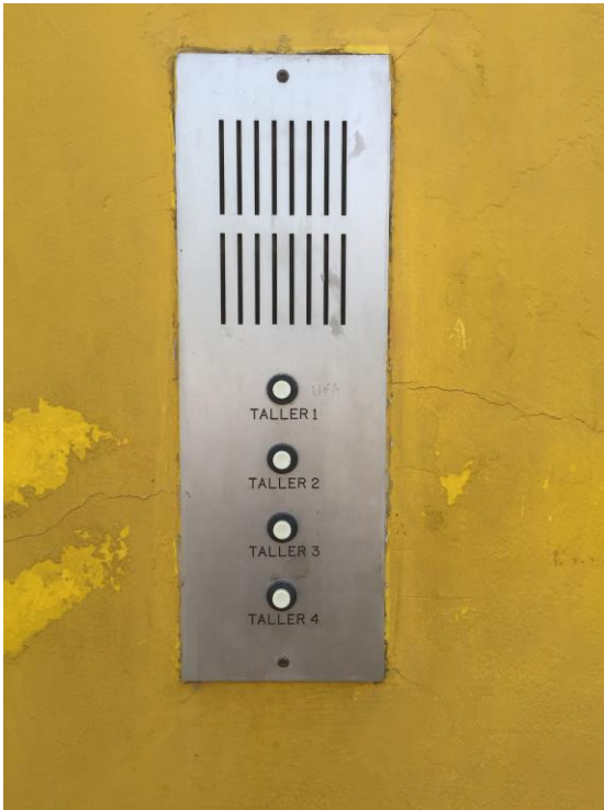
Ilustración 26 - Imágenes de cambios en fachada. Imágenes del autor.
