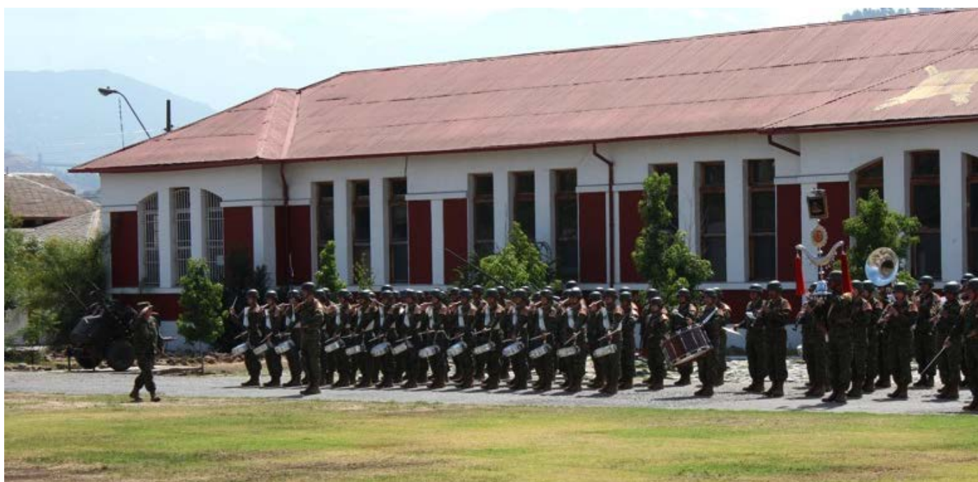
Imagen 15 Regimiento Buin en la actualidad, presenta edificaciones de valor histórico con un buen estado de conservación
