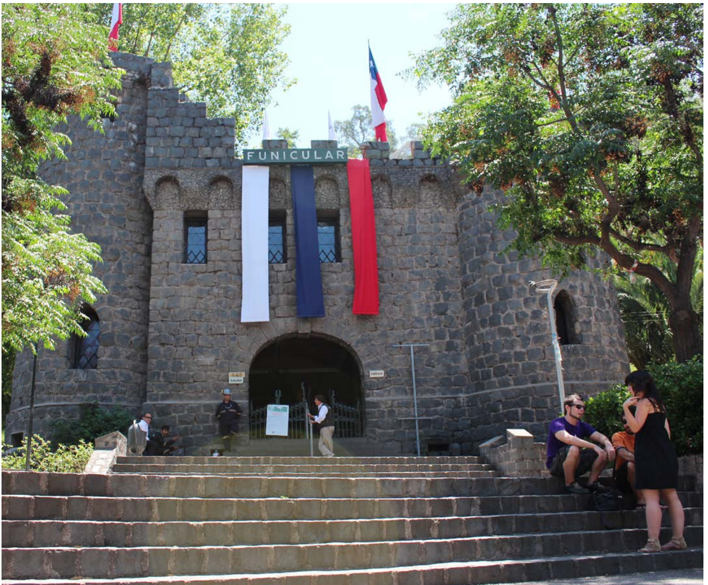
Imagen 5, Acceso Pio Nono, Estación Funicular Arqto. Luciano Kulczewski Fuente: Plataforma Arquitectura.
