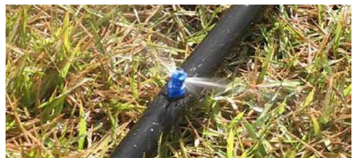
Sistema de Riego Por Goteo: areaverde.com.mx
