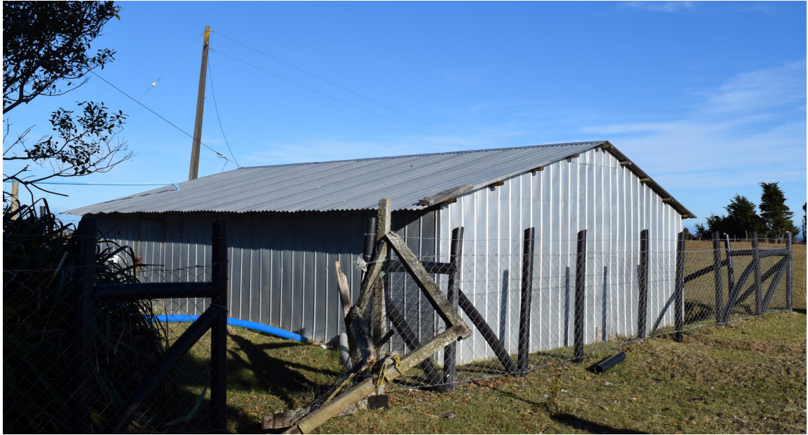
Imagen N°8 central de agua
