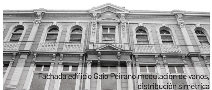
Fachada edificio Gaio Peirano modulación de vanos, distribución simétrica
