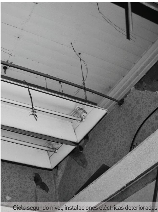
Cielo segundo nivel, instalaciones eléctricas deterioradas
