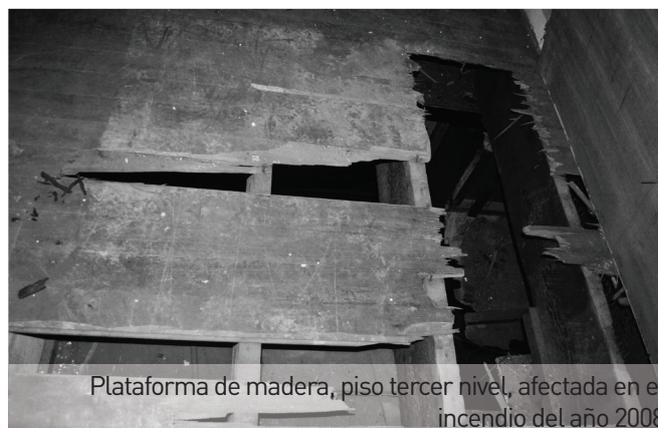
Plataforma de madera, piso tercer nivel, afectada en el incendio del año 2008
