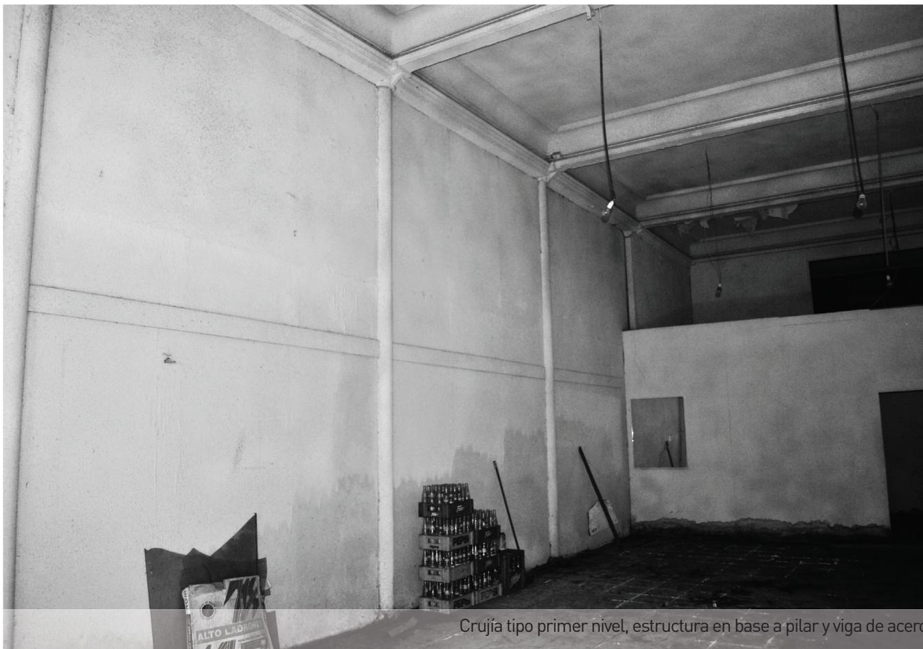
Crujía tipo primer nivel, estructura en base a pilar y viga de acero
