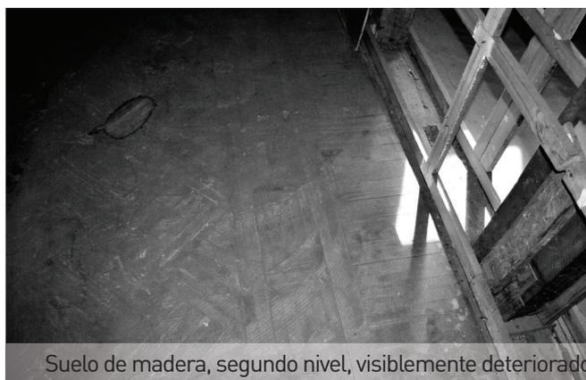
Suelo de madera, segundo nivel, visiblemente deteriorado
